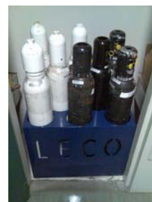
Gasflessen tegen omvallen beschermd.
